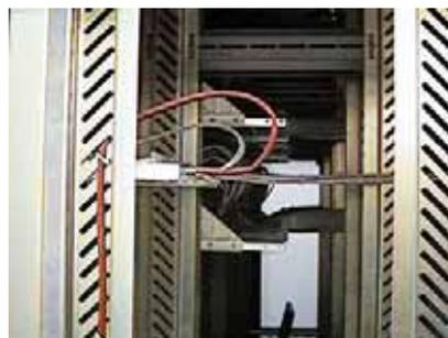
图 3.1 屏蔽配线架星型接地
