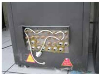
图 3.3 屏蔽机柜的进线波导管
