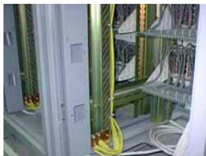
图 8.4 机柜内的接地导线
